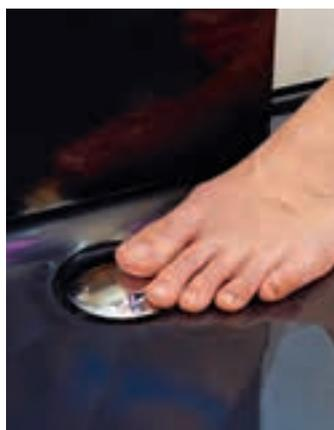
Dans l'écoulement de la douche, un dispositif protège contre les mauvaises odeurs et se ferme facilement avec le pied.
