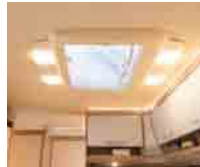
+ Gran claraboya Heki con iluminación LED: luz y ventilación en el interior
