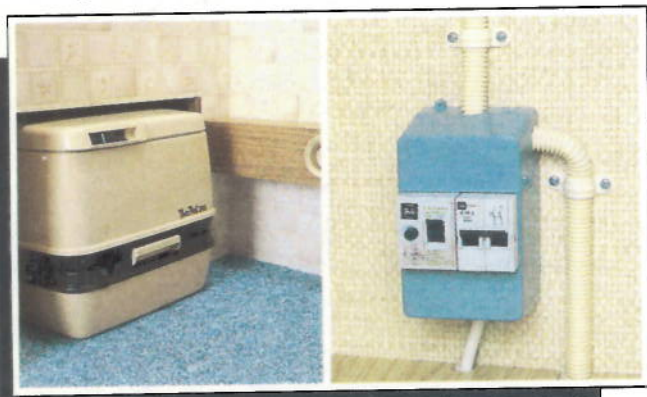
Aardlekschakelaar en zekeringautomaat, voor veiligheid.
